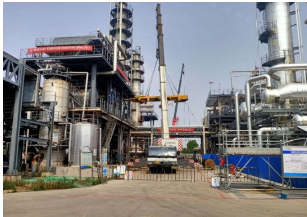
硫磺检修换热器施工
