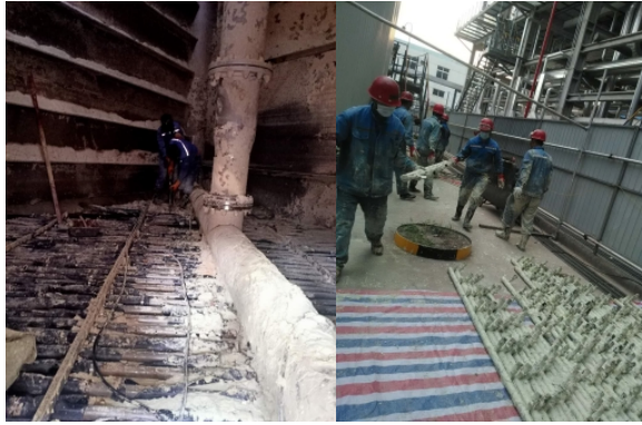
硫磺车间检修
